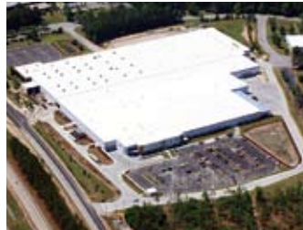
リッチランド工場外観
