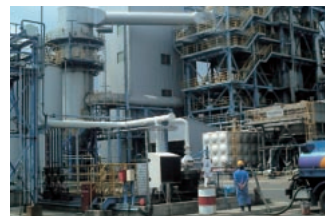
焼却施設の現地確認(2005年7月)
