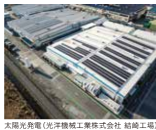
太陽光発電(光洋機械工業株式会社 結崎工場)
