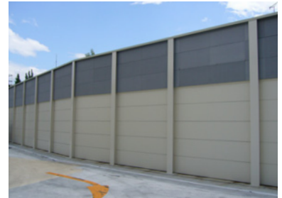
防音壁(奈良工場)
