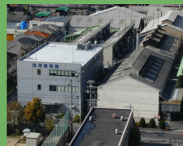
主サイトである八尾工場(大阪府)
