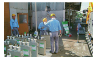
PCB機器処理状況(徳島工場)
