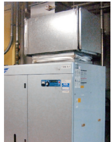
コンプレッサーにダクトを設置 (田戸岬工場内新南工場)
