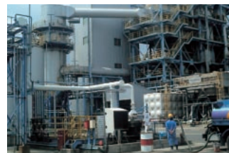
焼却施設の現地確認(2005年7月)
