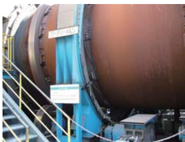
焼却施設の現地確認(2007年3月)
