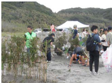
堆砂垣作りによる砂浜の再生
