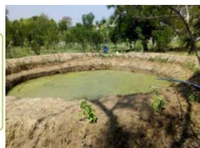
改修した雨水貯蔵池
