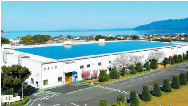
Solar power generation (Kagawa Plant)
