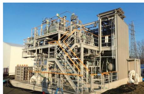
図7 変動再エネ水素対応アンモニア製造プラント
