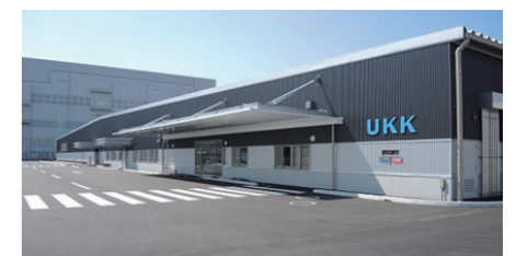
宇都宮機器 清原新工場 (栃木県宇都宮市清原工業団地内)
