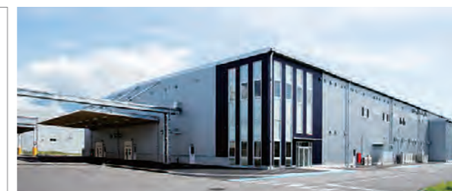
高耐熱リチウムイオンキャパシタ生産工場
