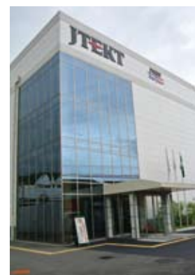
大型軸受技術開発センター
