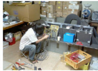
配線系を処理していきます
