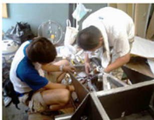
モータのコントローラ を取り付けています
