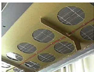
ソーラーパネルの 配線の最終チェッ ク
