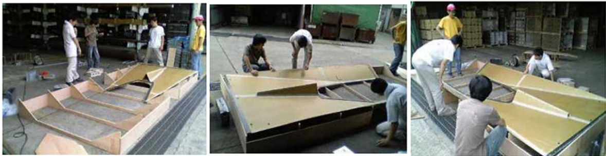
ボディの下面部の製作、まず、型枠を作り、型に合わせてFRP材を接合していきます
