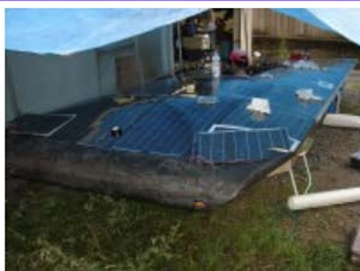
傷んだソーラーパネルの張り替えです
